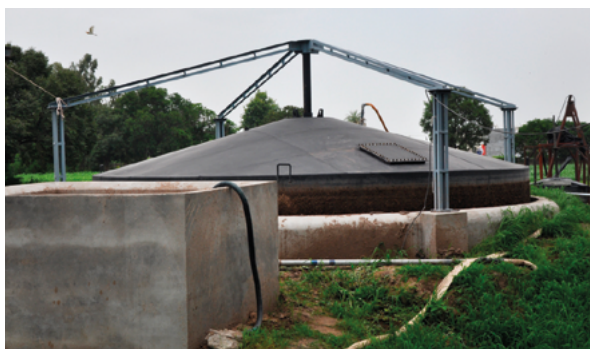
Die Gau Farm nutzt Strom aus eigener Biogasanlage
