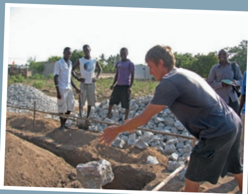
Baubeginn eines Lagerhauses, Mocuba, Mosambik, 2013, ©Marlise Schlötterer
