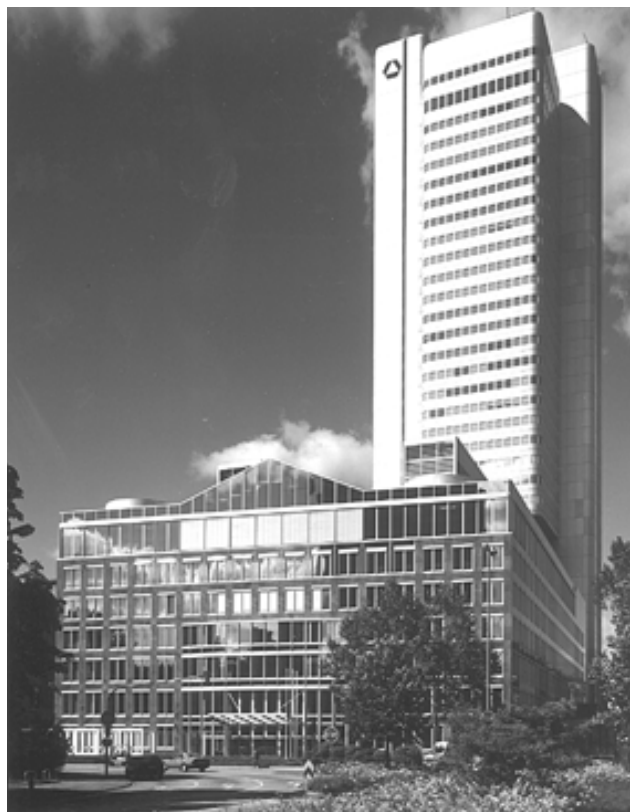
Verwaltungs- und Bankgebäude der Dresdner Bank AG in Frankfurt/Main.
